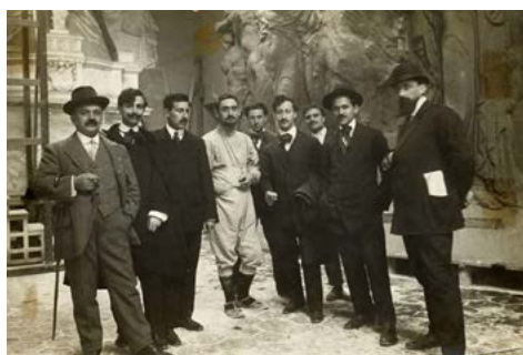
4. Lo scultore Angelo Zanelli (al centro, in tuta chiara da lavoro) con alcuni collaboratori e visitatori nel cantiere dove furono realizzate le monumentali sculture © MiC, VIVE - Vittoriano e Palazzo Venezia
